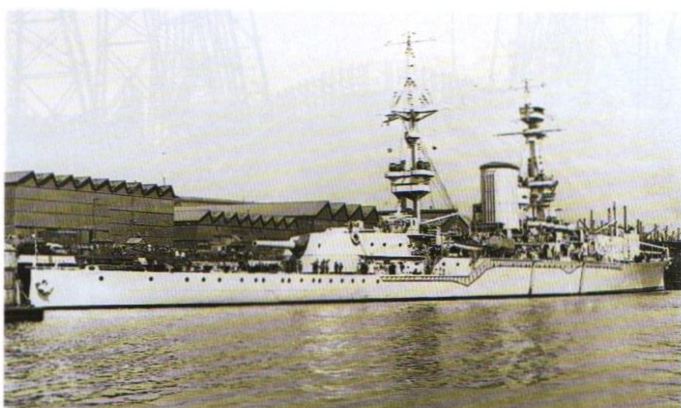
L'incrociatore da battaglia FURIOUS durante l'allestimento: a poppa è visibile la torre singola con il nuovo cannone da 18 pollici (457 mm), in seguito sbarcato per completare la trasformazione dell'unità in portaerei.
