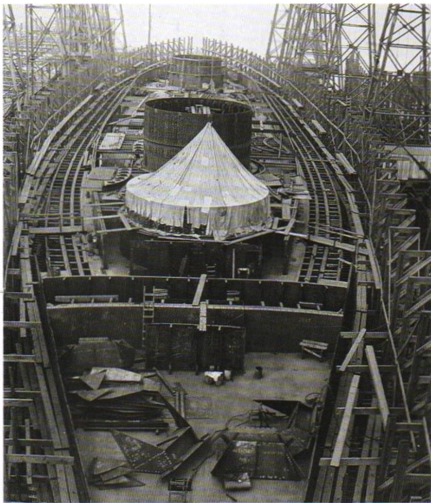
La costruzione della corazzata SOUTH DAKOTA, qui in una foto del 1922 presso il cantiere navale di New York dell'US Navy, fu sospesa in conseguenza del Trattato di Washington: l'unità avrebbe dovuto imbarcare 4 torri trinate con cannoni da 16 pollici.
