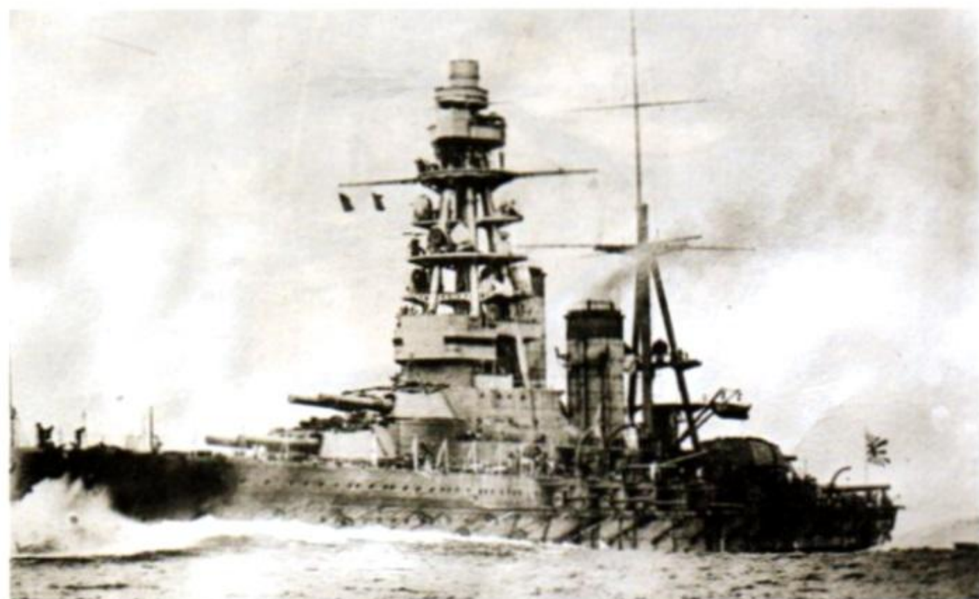
Una foto, non di eccelsa qualità, della corazzata giapponese MUTSU nel 1922. Gemella della NAGATO, l'unità sarà estesamente rimodernata negli anni trenta, mantenendo peraltro inalterato l'armamento principale su 8 cannoni da 410 mm.
